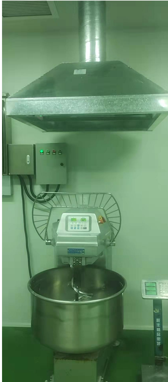
图 3.2-1 废气收集装置
