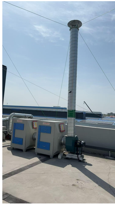
图 3.2-2 喷码、包装、封口废气收集装置
