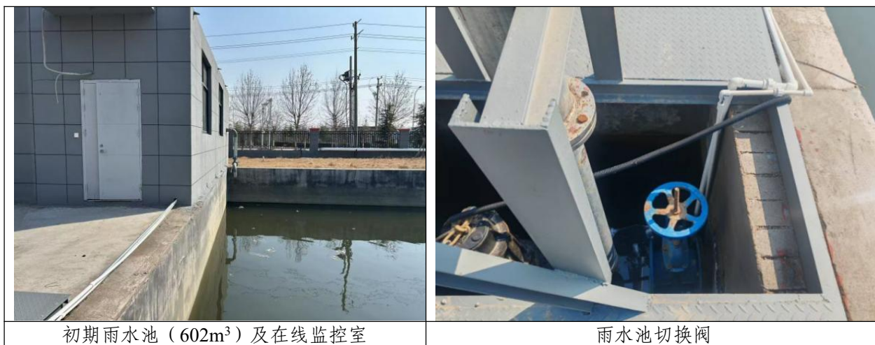
图4.2-2 新建初期雨水池
