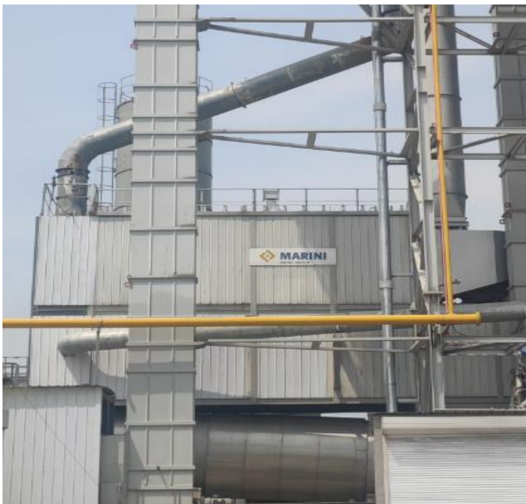
图 3-4 烘干废气脉冲布袋除尘装置
