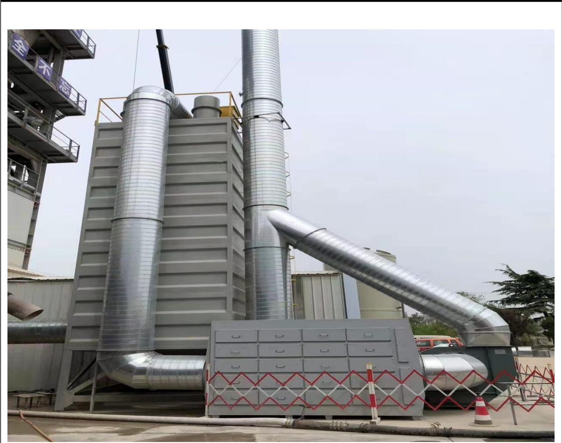
图 3-2 沥青烟废气收集装置
