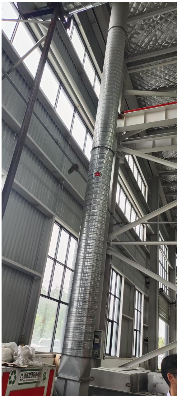
浇注固化排气筒检测口
