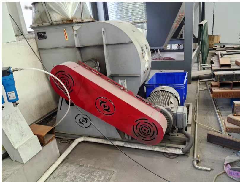
减震基座（样图，其他设备同类）
