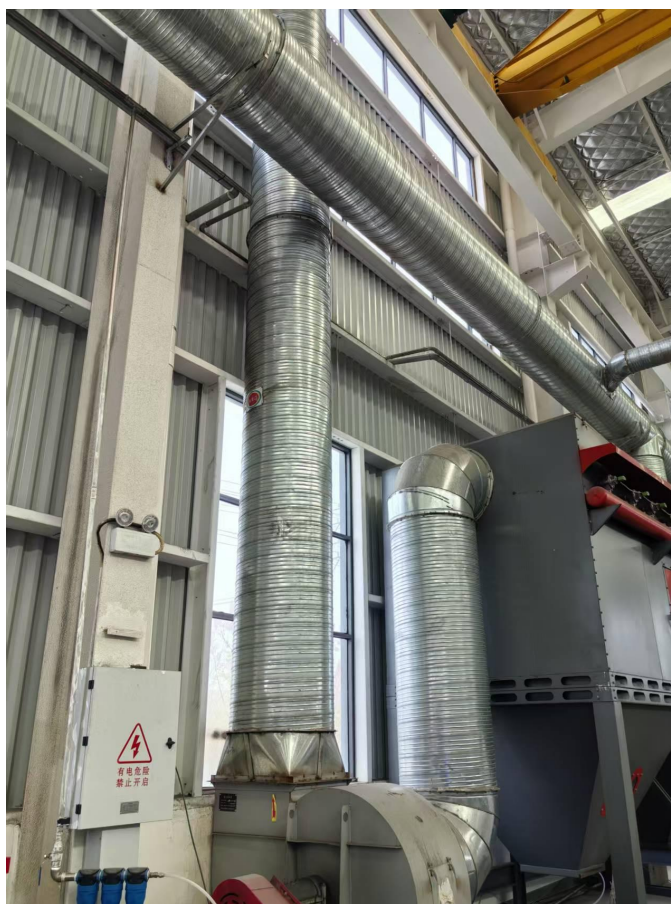
下料、焊接排气筒检测口
